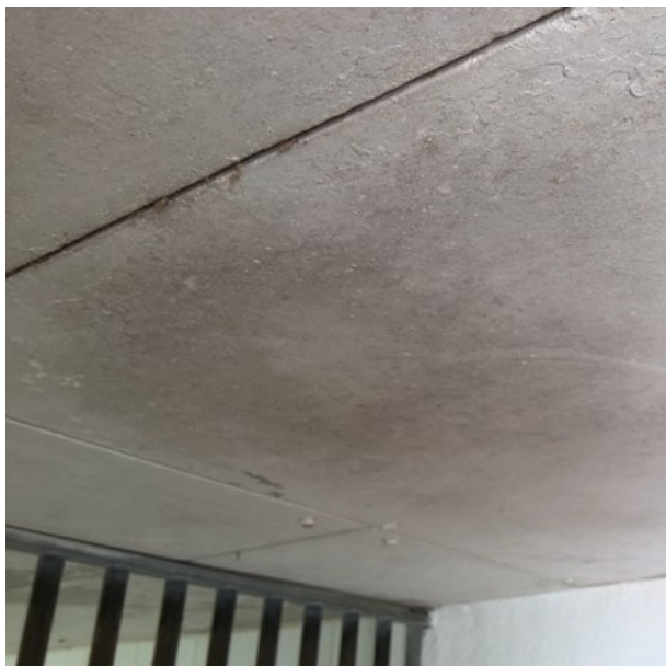
Niv 00 / ROU040 / 04-004 / Plaque en fibres-ciment plafond [ Prélèvement n°88]
