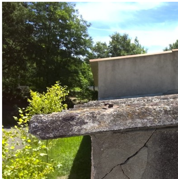
Niv 00 / ROU040 / 04-004 / Plaque en fibres-ciment toiture [ Prélèvement n°89]
